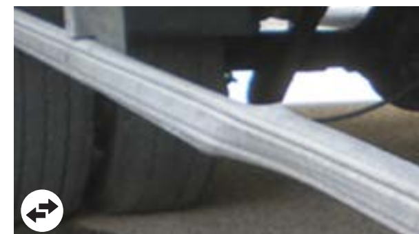
Barres cyclistes: déformation hors limite économique de la réparation
