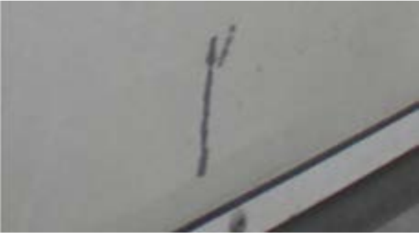
Portes latérales et arrières: déformations légères: temps de réparation ≤ 1 h
