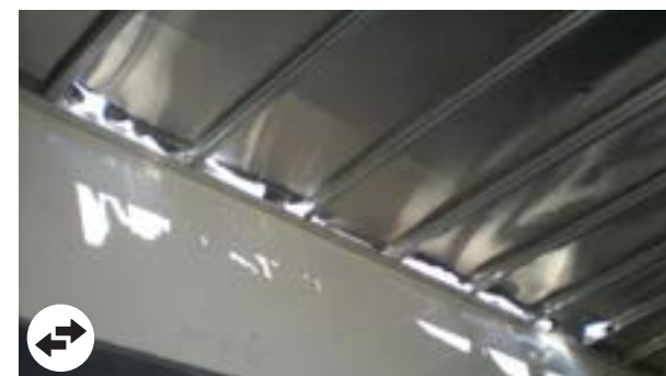
Pavillon: Cadre endommagé, peausserie hors limite économique de la réparation
